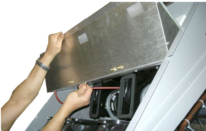
- Retire los tubos de silicona roja y a continuación la cámara de los ventiladores.
