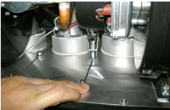
- Retire los tornillos "A" para cada elemento (con llave de boca de 13 mm).
