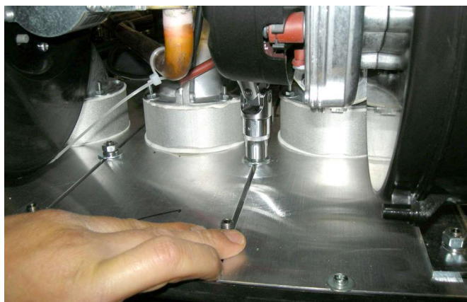
- Retire los tornillos "A" para cada elemento) con llave de boca y llave plana de 13mm).
