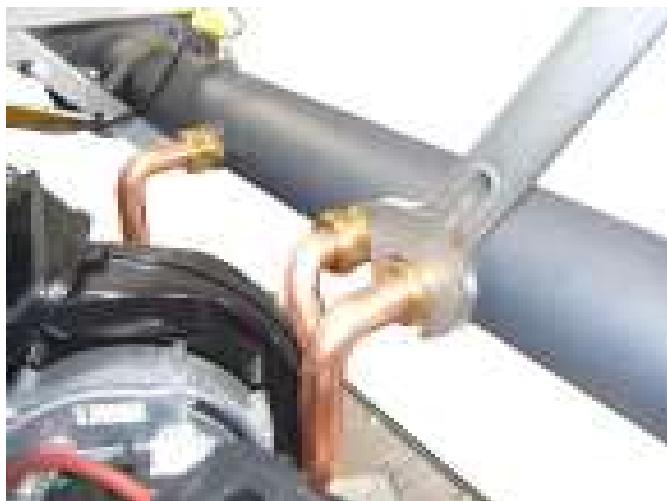
- Retire los racores del gas desde el colector de gas, con llave plana de 36 mm.
